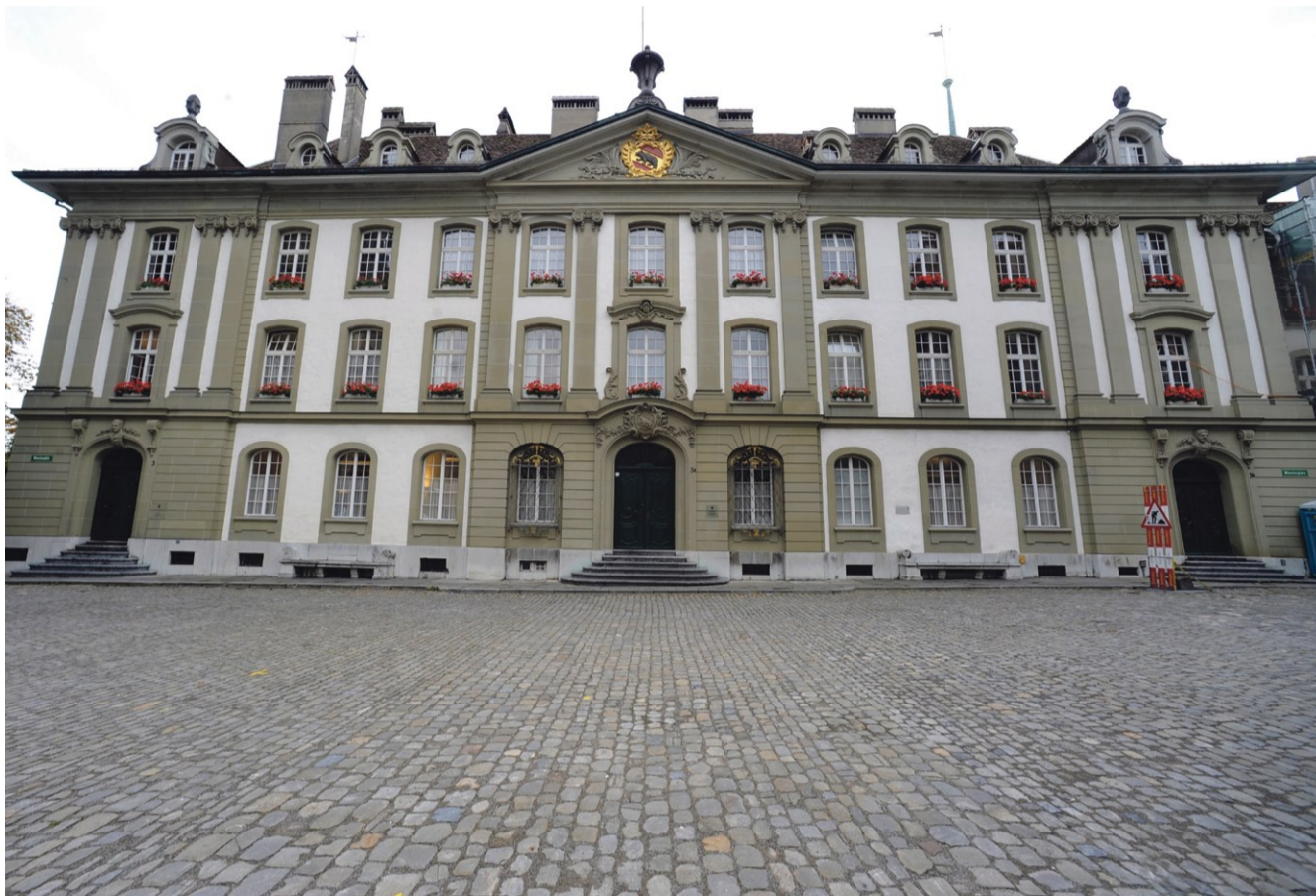
Die bernische Verwaltung - hier der Sitz der Volkswirtschaftsdirektion am Münsterplatz - gilt als effizient. Foto: Franziska Scheidegger
